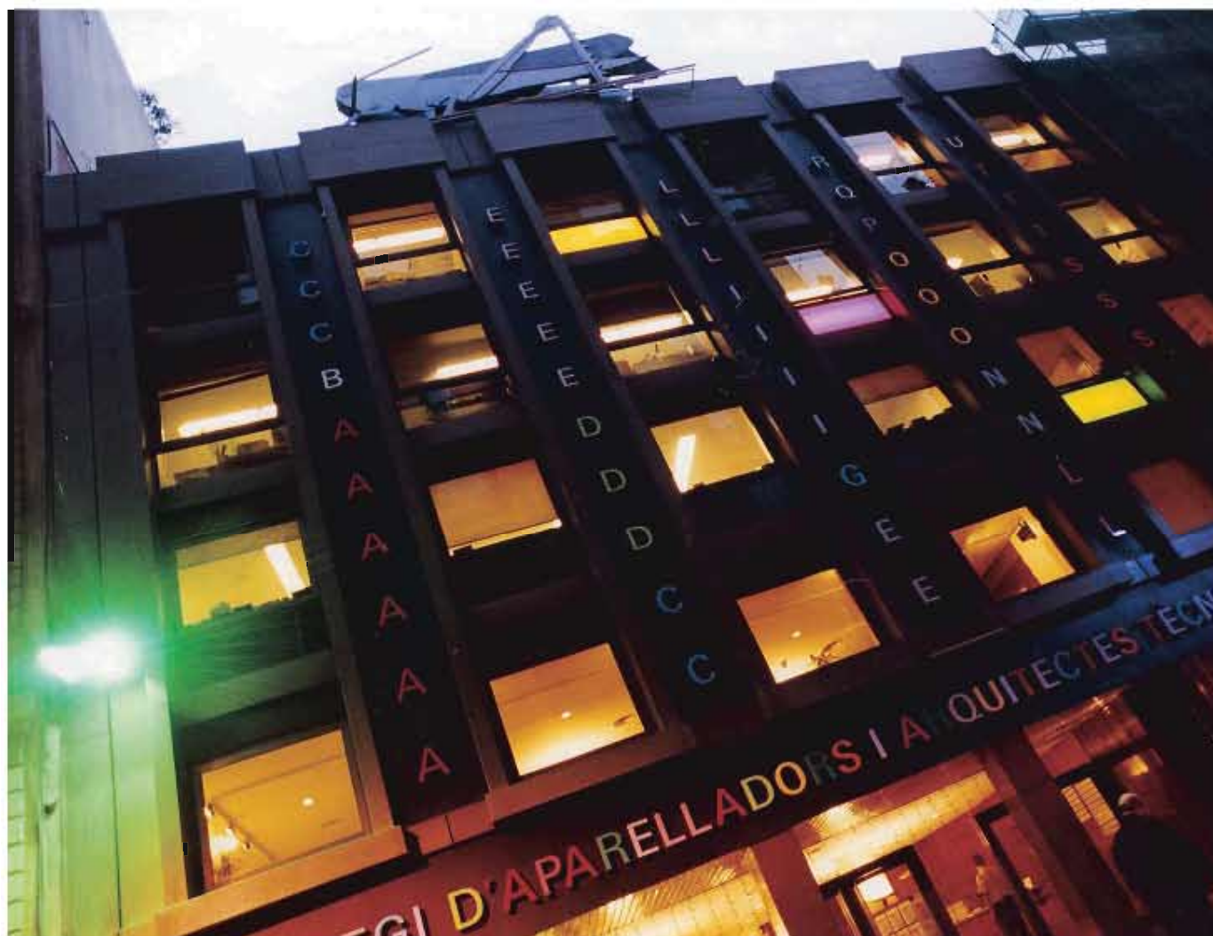
La inconfusible façana del CAATB, dissenyada per Joan Brossa
