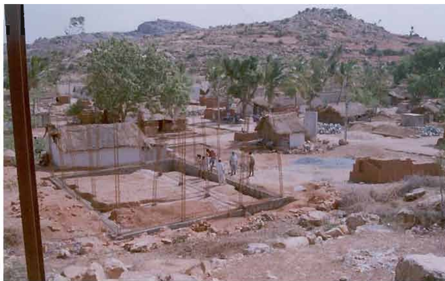
Aspecte de les obres de la nova escola
