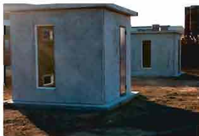
Cubicles amb PCM en el formigó, instal·lats a Puigverd de Lleida
