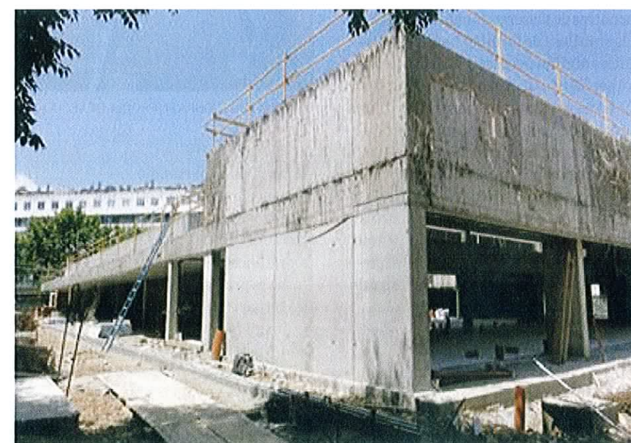
EL CANYÍS HA ESTAT UTILITZAT PER ENCOFRAR EL FORMIGÓ
