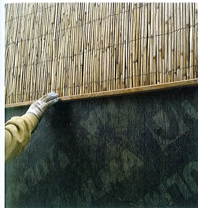
EL CANYÍS HA ESTAT UTILITZAT PER ENCOFRAR EL FORMIGÓ
